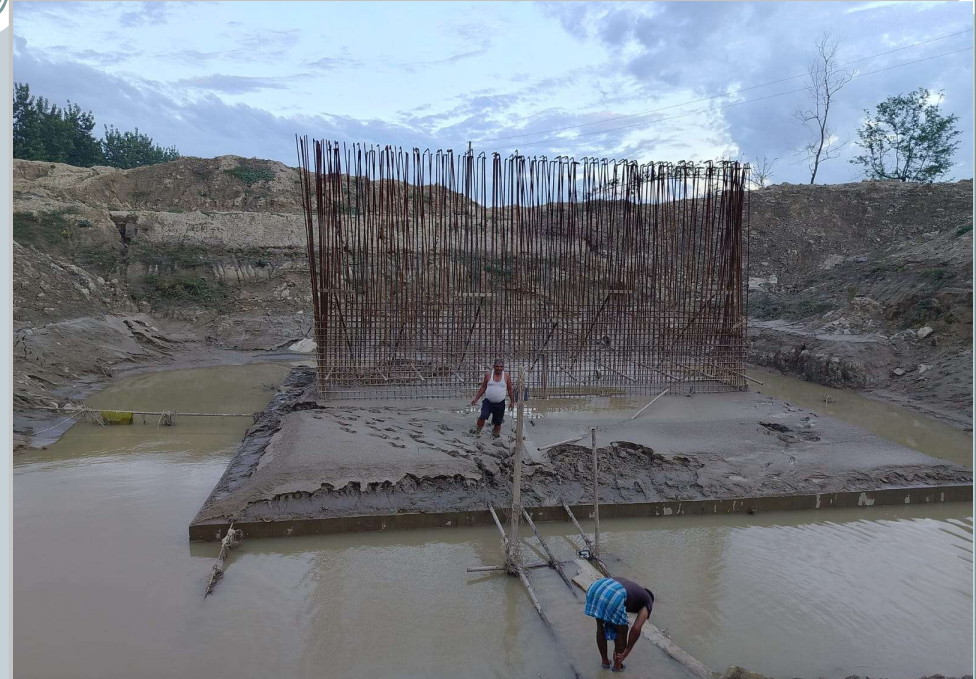
तुरीया खोला सडक पुल, सुकौली घिनाहा रामग्राम वडा नं. १५, रामग्राम न.पा., नवलपरासी (ब.सु.प.) (45m PSC)
