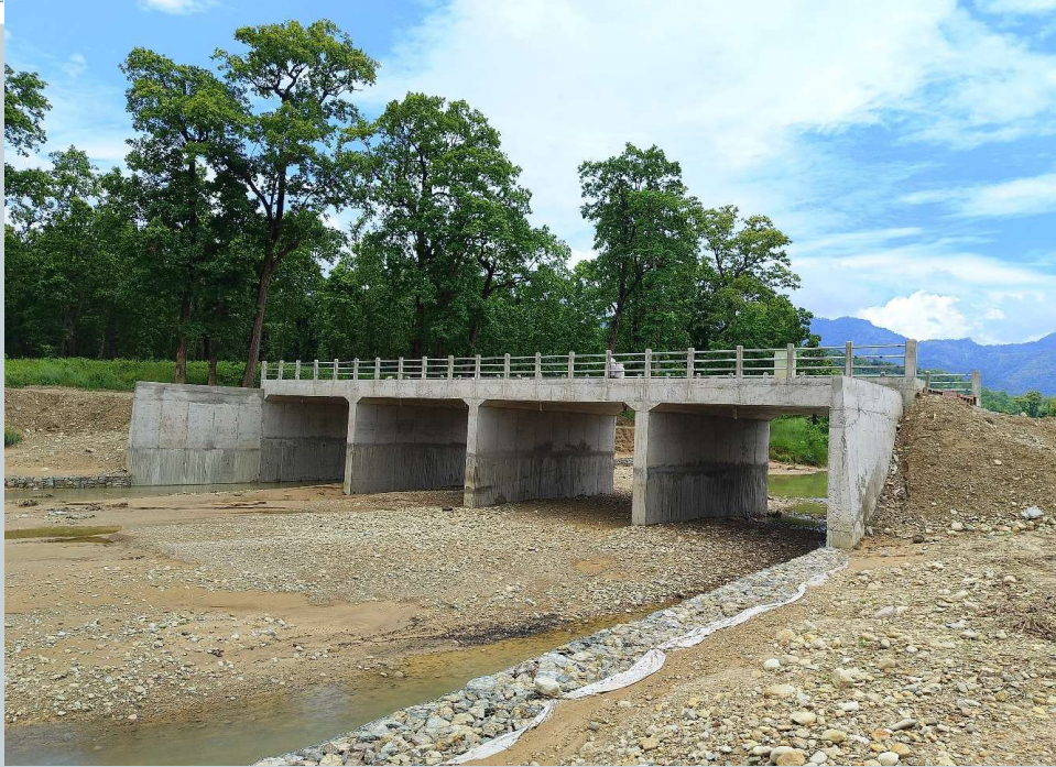
सोमनाथ खोला पुल (तिलकनाघाट र सितलपानी पुल सहित), सुनवल ६ तिल्कहना विसासय जोडने सडक, नवलपरासी (ब.सु.प.) (4x7x5m Box)
